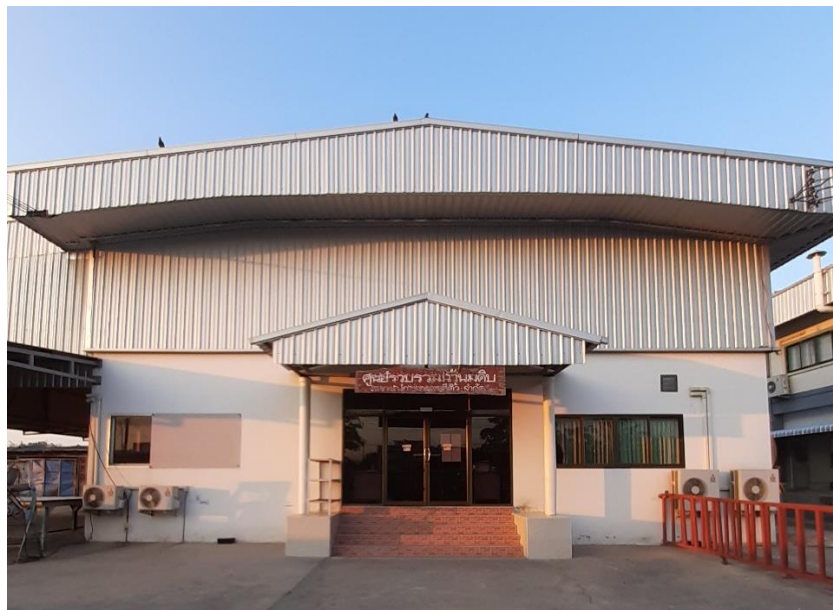
ภาพที่ 12 แสดงอาคารศูนย์รวบรวมนํ้านมดิบ
