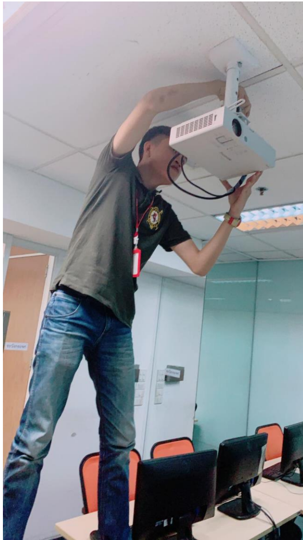
ภาพที่ 17 ติดตั้งโปรเจคเตอร์ภายในห้องเรียน
