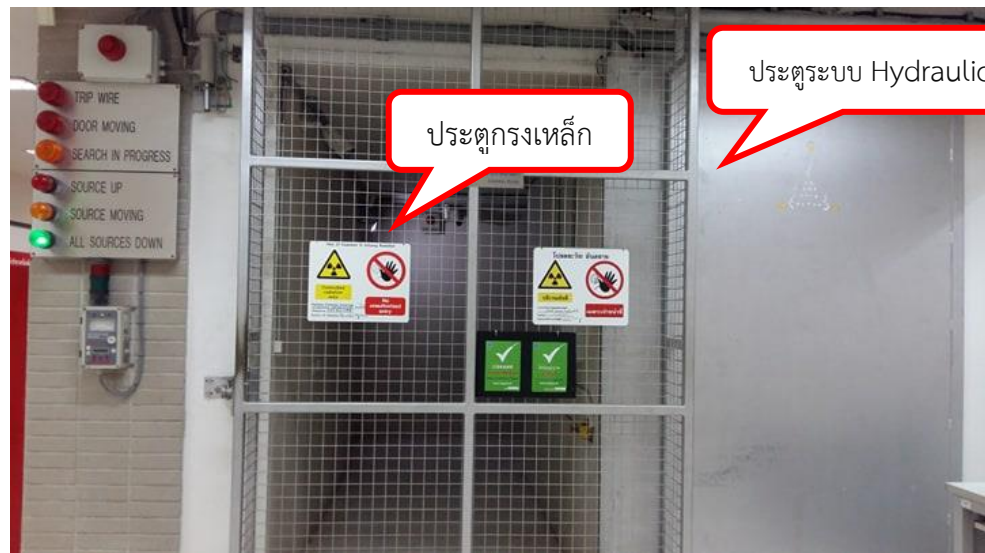
ภาพที่ 3.30 ระบบประตู Hydraulic เปิดออก
