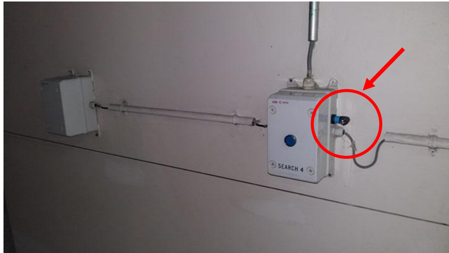
ภาพที่ 3.35 ระบบตรวจสอบว่าไม่มีบุคคลใดอยู่ภายในห้องฉายรังสี
