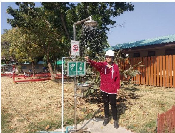
ภาพที่ 1-31 ตรวจสอบอ่างล้างตาฉุกเฉิน
