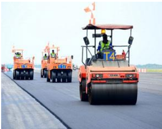
ภาพที่ 1-15 โหมดิฟายด์แอสฟัลทซิเมนต์เกรดพิเศษ
