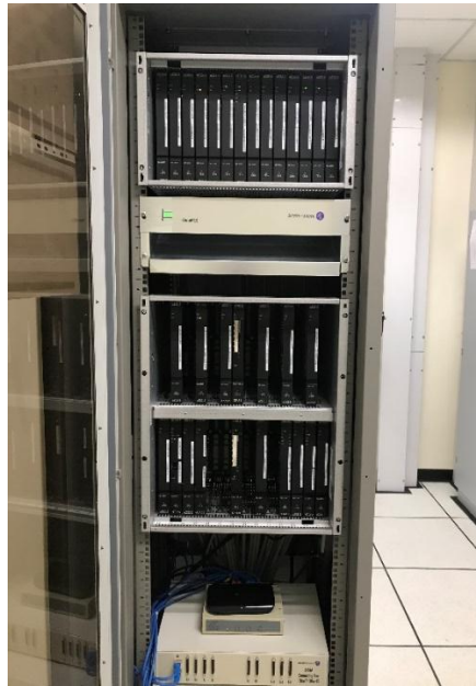
ภาพที่ 4.60 ตรวจสอบห้องเซิร์ฟเวอร์
