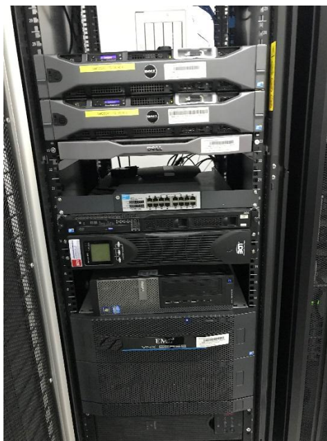
ภาพที่ 4.57 ตรวจสอบห้องเซิร์ฟเวอร์
