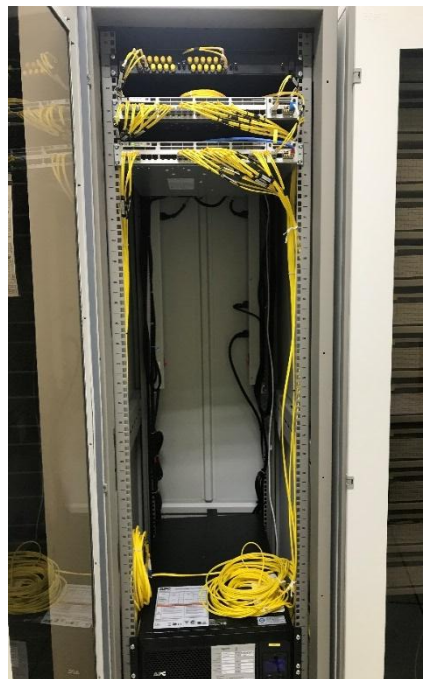
ภาพที่ 4.61 ตรวจสอบห้องเซิร์ฟเวอร์
