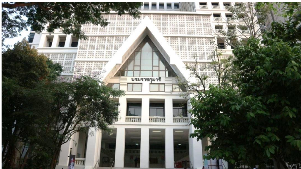
ภาพที่ 2 อาคารบรมราชกุมารี
