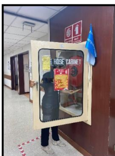
ภาพที่ 1-5 การตรวจสอบถังดับเพลิง
