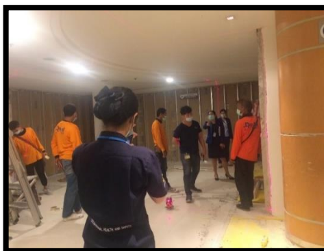
ภาพที่ 1-12 การประเมินความเสี่ยงในระหว่างงานก่อสร้าง
