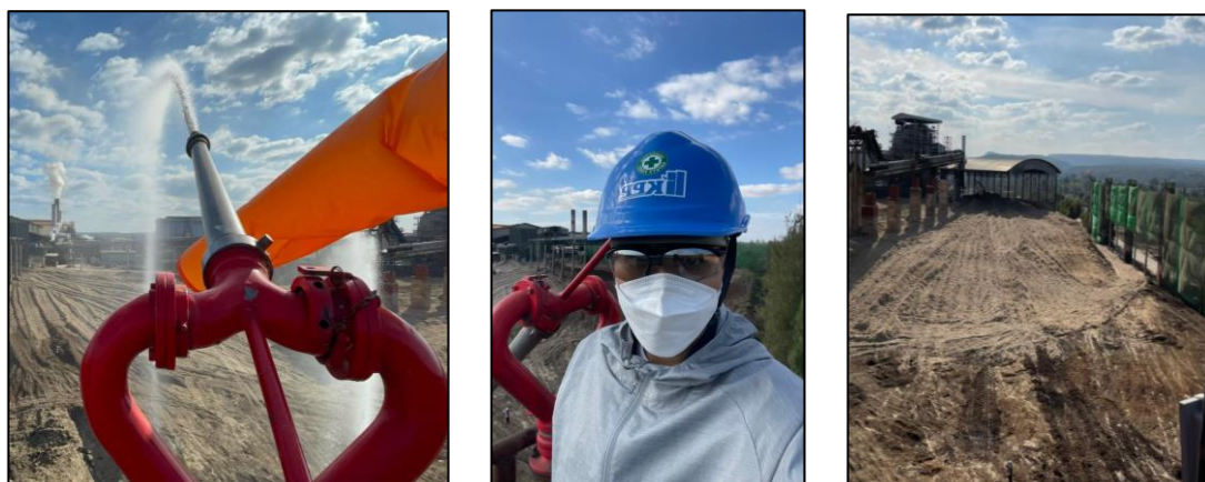
ภาพที่ 1.18 ทดสอบฉีดน้ำดับเพลิงบนเสาทาวเวอร์
