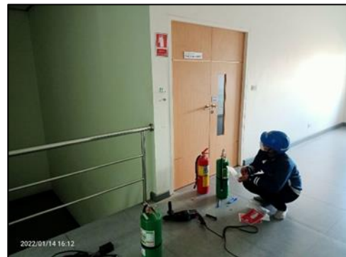
ภาพที่ 1.20 เปลี่ยนถังดับเพลิงที่ชำรุด และ ติดตั้งถังดับเพลิงใหม่เพิ่มเติม
