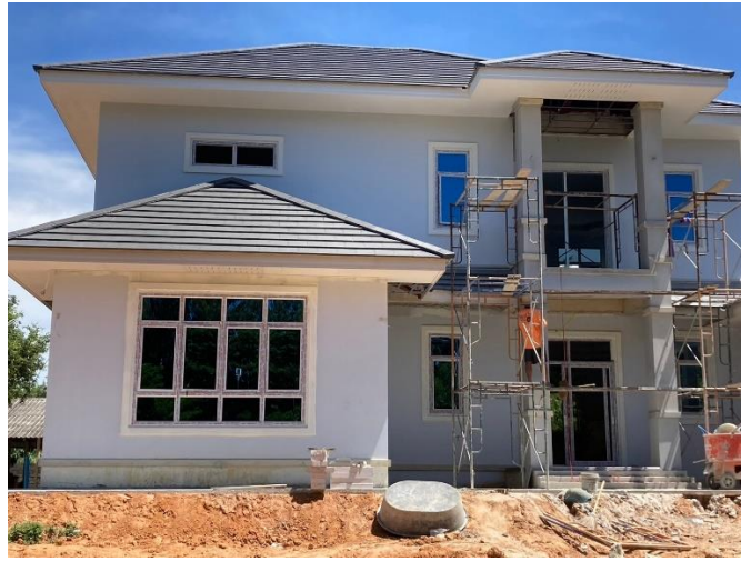
การติดตามดูงานรับเหมาก่อสร้างของบริษัท ฟ้าประทานกิจการ จำกัด
