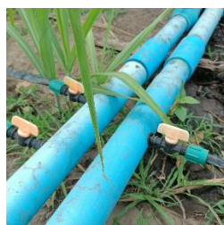
ภาพที่ 8 ต่อท่อระบบน้ำ
