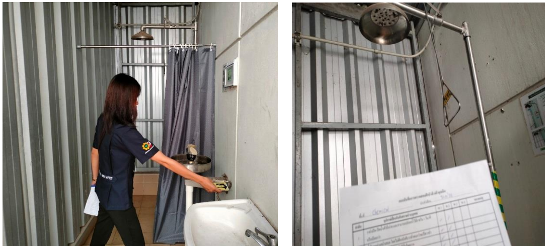
ภาพที่ 8 ตรวจสอบฝักบัวและอ่างล้างตาฉุกเฉิน ประจำทุกสัปดาห์
