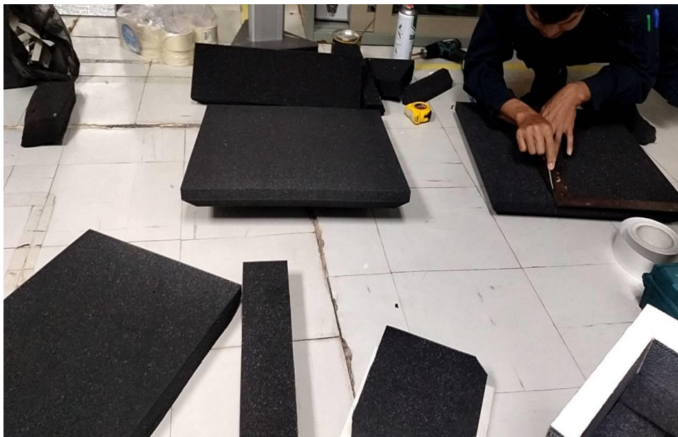
ภาพที่ 4 ออกแบบการติดตั้งวัสดุดูดซับเสียง ด้านบน – ด้านล่าง และจัดทำกรวัดขนาดและตัดอุปกรณ์ที่ใช้ในการติดตั้งวัสดุดูดซับเสียง
