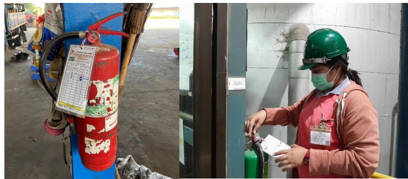
ภาพที่ 20 จัดทำป้ายตรวจถังดับเพลิงและนำไปติดพื้นที่หน้างาน
