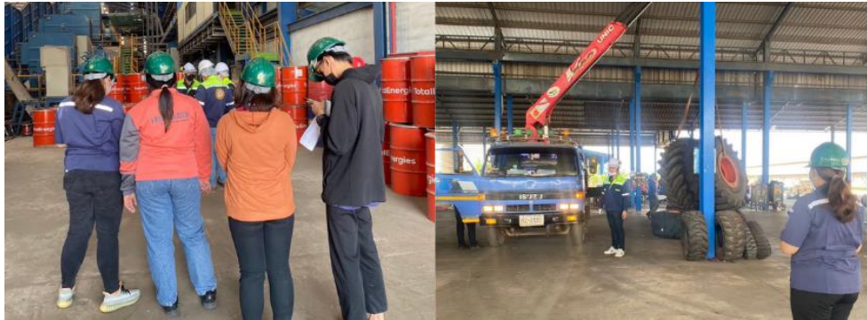
ภาพที่ 37 ตรวจสอบเครนร่วมกับหน่วยงานภายนอก
