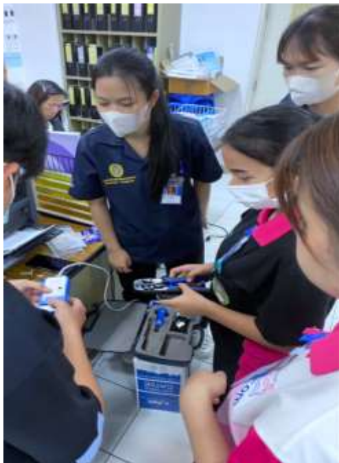
ภาพที่ 4.13 ฝึกต่อหัวและติดตั้งสาย LAN
